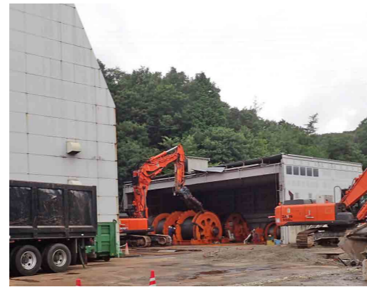
巻上機室解体の様子
